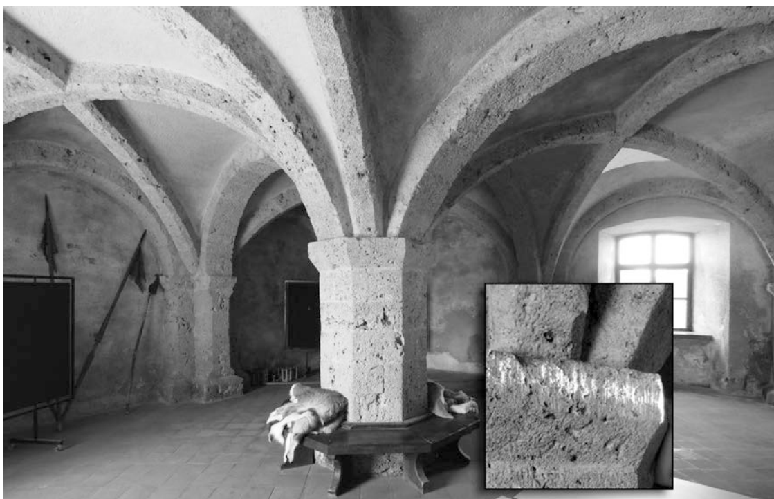
Abb. 11: Gewölbe im Palaserdgeschoss der Hauptburg, Detail: Steinbearbeitung (Aufn.: Stephan Hoppe 2016, Bearb.: Verfasserin)
